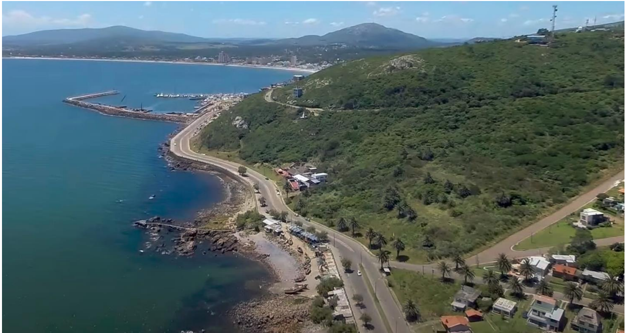
Figura 1: Ubicación de la construcción: Muelle Stella Maris
